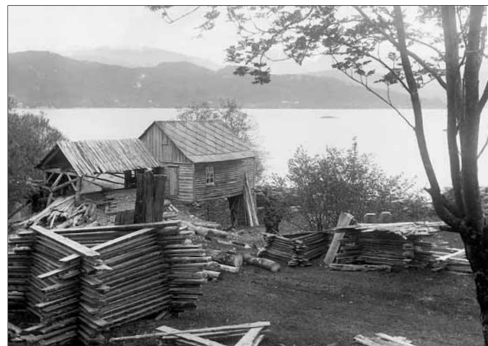
Byrkjelandssaga i Vikøy, Kvam i 1912. Her ligger de karakteristiske bordstablene med båtboard og kledningsbord. Behovet for breie bord til båtbyggingen har holdt oppgangssagene i bruk helt opp til vår tid.
