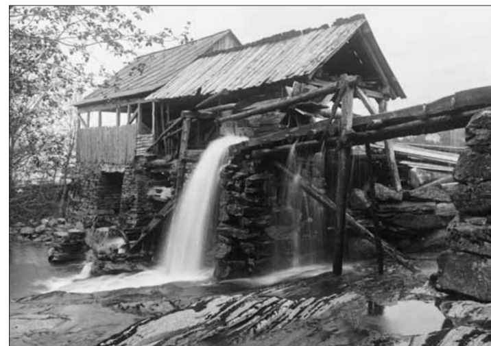
Byrkjelandssaga i Vikøy, Kvam i 1912. Her ligger de karakteristiske bordstablene med båtboard og kledningsbord. Behovet for breie bord til båtbyggingen har holdt oppgangssagene i bruk helt opp til vår tid.
