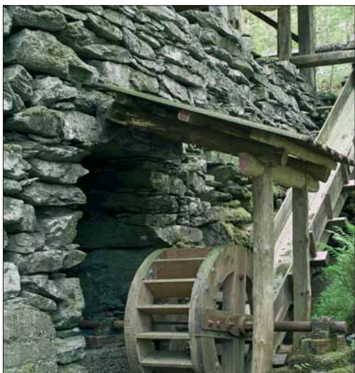
Det store vasshjulet var det sentrale drivverket i oppgangssagene. Stekka, Tørvikbygd.
