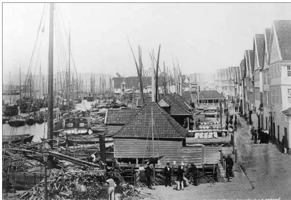
Bryggen med vippebommene gjev eit talande bilete av det tette sambandet mellom bygdene og byen – og fernare himmelstrøk.
