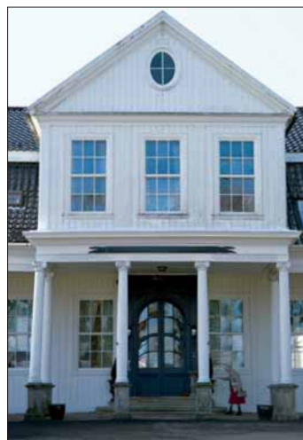
Hovudinngangen på Hop har framleis den søyledekte fasaden frå slutten av 1700-talet.
