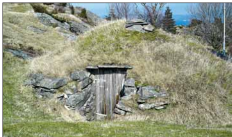
Jordkjellarane, Nordhordlands «stabbur», er ein karakteristisk del av byggeskikken i kystbygdene.
