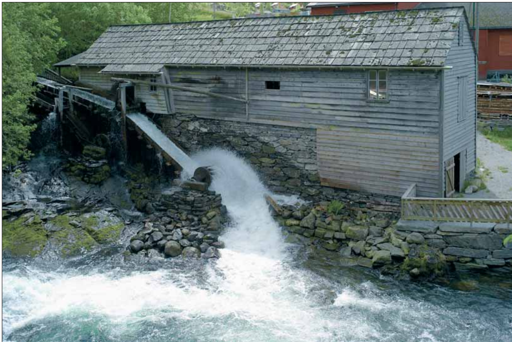
Både oppgangssaga og sirkelsaga er vassdrivne.
