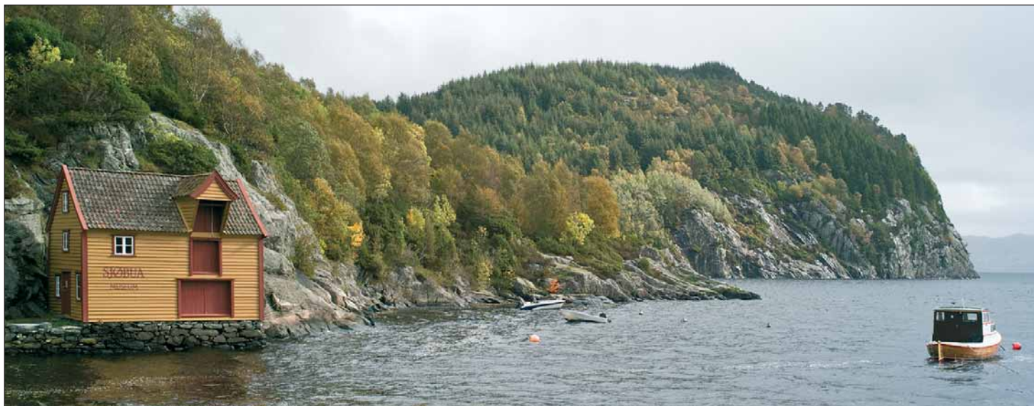
Sjøbua på Holmeknappen vart restaurert i 1992.
