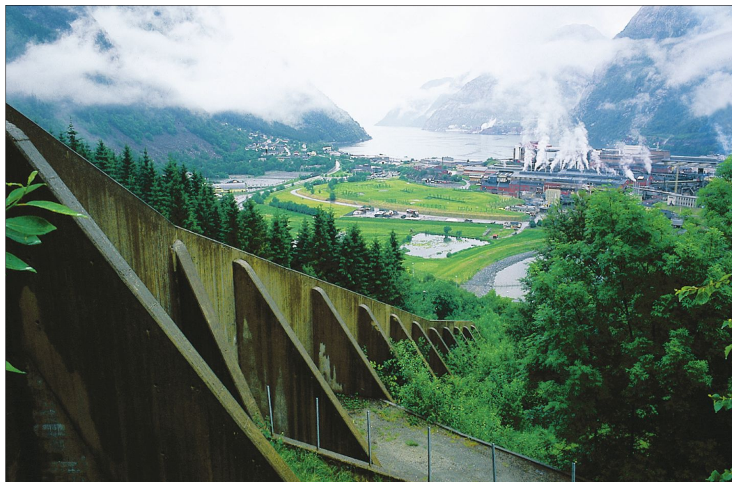
Eitrheimsneset med «Zinken», sett frå Tokheim. Delar av Eitrheimsvågen er utfylte og omgjorde til golfbane. Dei store betongmurane i framgrunnen er bygde for å leia snøskreda ut til sidene, bort frå busa på Tokheim. (Svein Nord)
